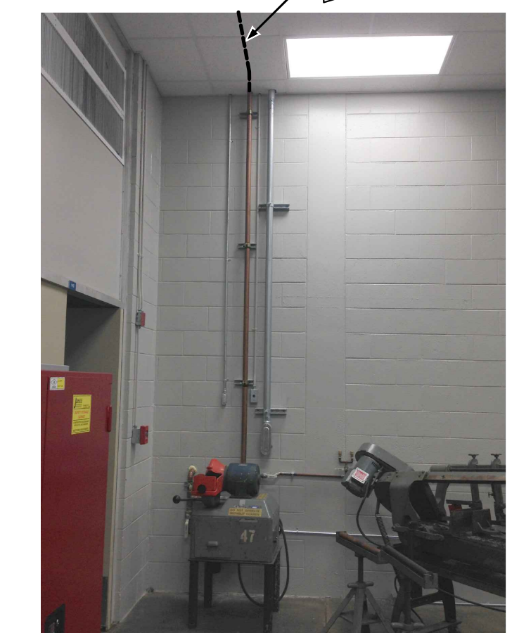
2 EXISTING COMPRESSED AIR PIPING N.T.S.
